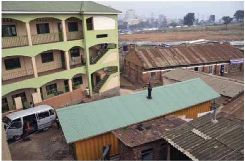
Kontti valmiina ja maalattuna.
