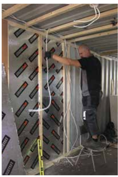
Ilkka sähköjä vetämässä.
