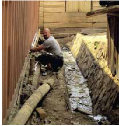
Imu- ja viemäriputkien asentamisista. Vieressä paikallinen viemäri.
